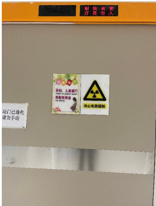
电动推拉门上警示灯、电离辐射警告标志、防护注意事项
