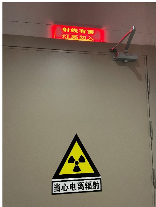
手动平开门上警示灯、电离辐射警告标志、自动闭门装置
