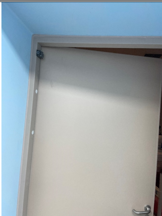
手动平开门上门灯联动装置
