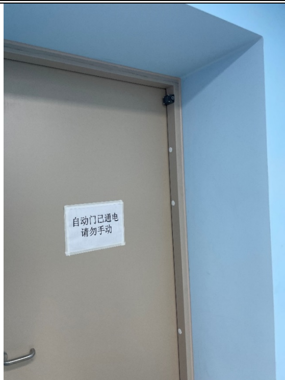
电动推拉门上门灯联动装置
