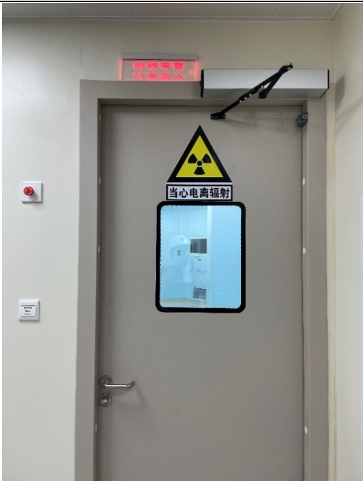
电动平开门上门灯联动装置、闭门装置、电离辐射警告标志
