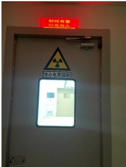
手动平开门上警示灯、电离辐射警告标志、自动闭 门装置、门灯联动装置
