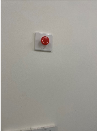
机房内墙面急停装置
