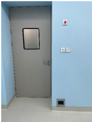
机房内墙面急停装置
